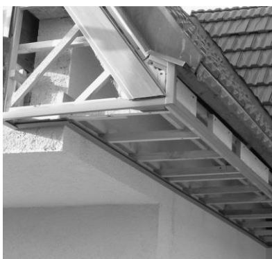
osazené ukonč. profily a první lamela
