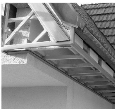
osazené ukonč. profily a první lamela
